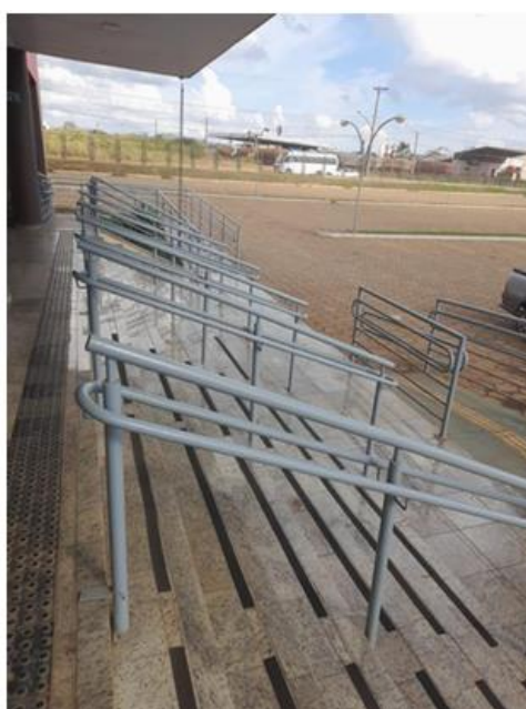
Instalação de Corrimãos para Melhoria de Acessibilidade
