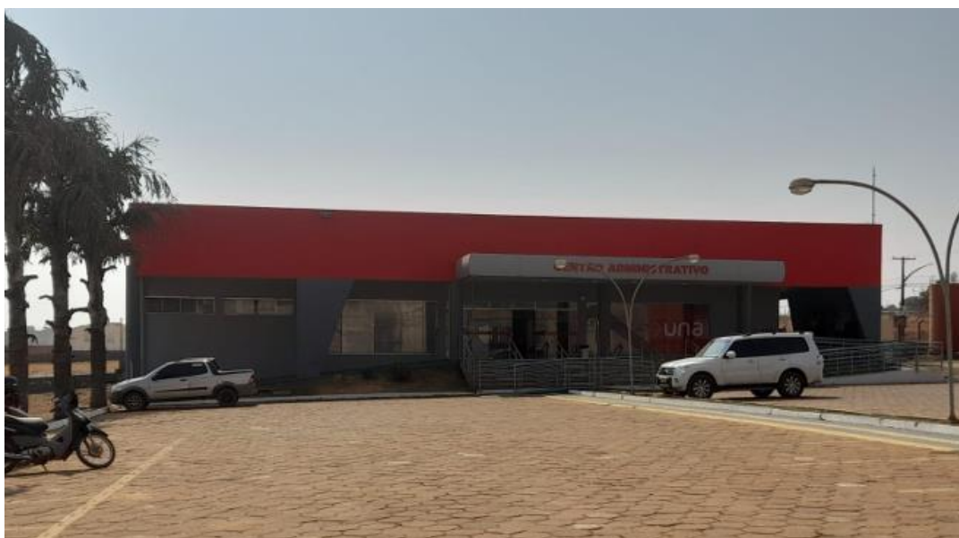
Reforma no Bloco Administrativo
