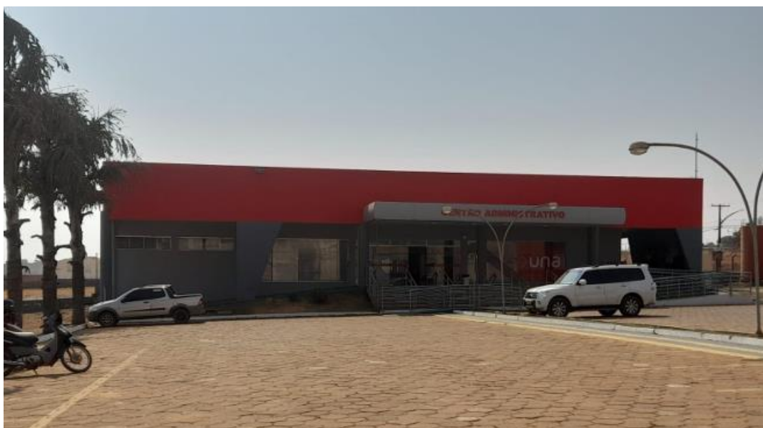
Reforma no Bloco Administrativo
