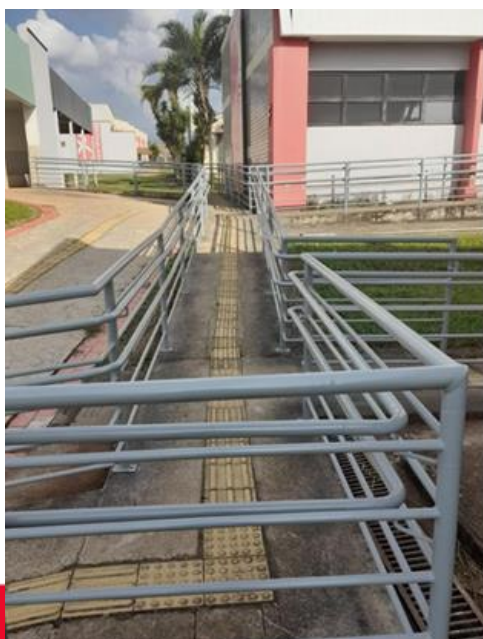
Instalação de Corrimãos para Melhoria de Acessibilidade
